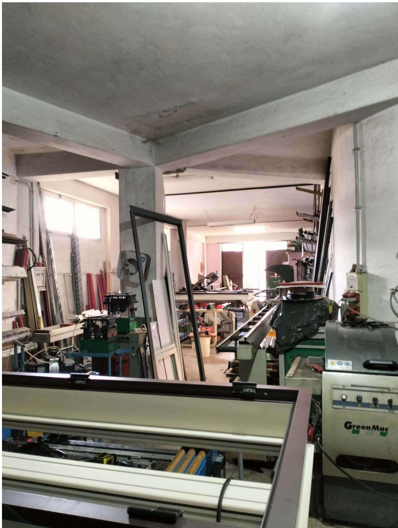
FOTO INTERNE LOTTO 1 – DEPOSITO – SUB.2
